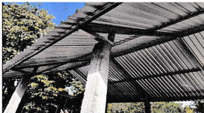
Foto 3: Sustitución de techo de cocina.
