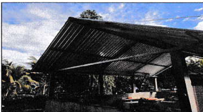
Foto 4: Colocación de estructura metálica y techo de la cocina.
