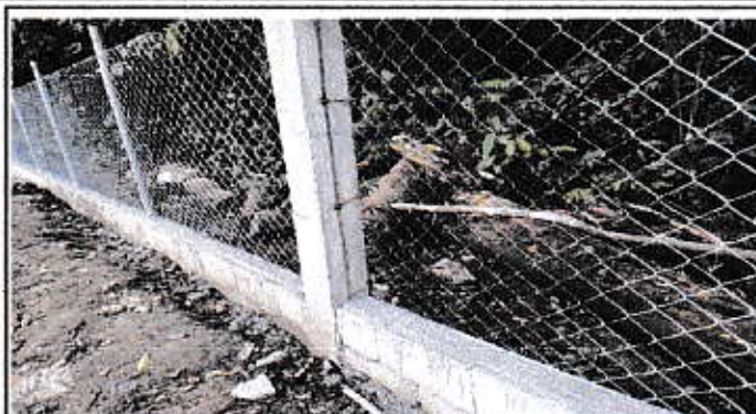
Foto 2: Colocación de malla perimetral.
