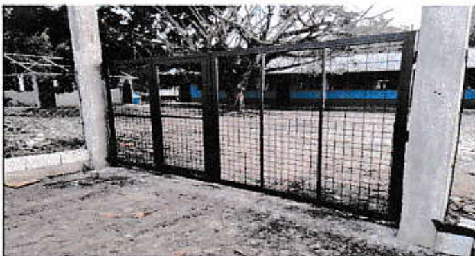
Foto 6: Instalación de segundo portón de acceso al establecimiento.
