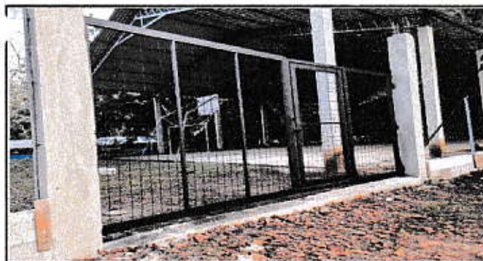
Foto 5: Colocación de portones en los accesos del establecimiento.
