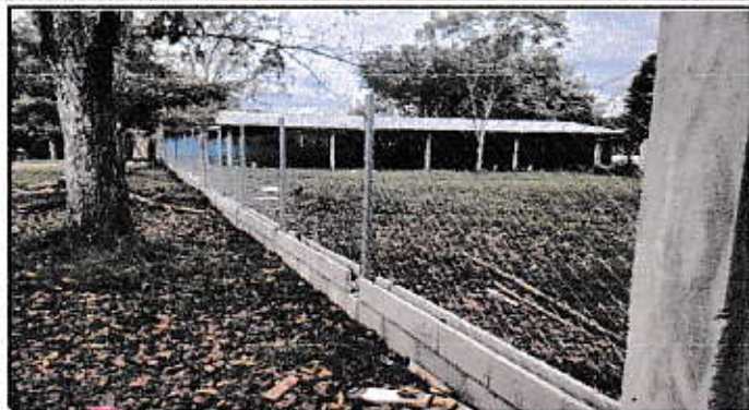
Foto 1: Colocación y fundición de malla metálica.
